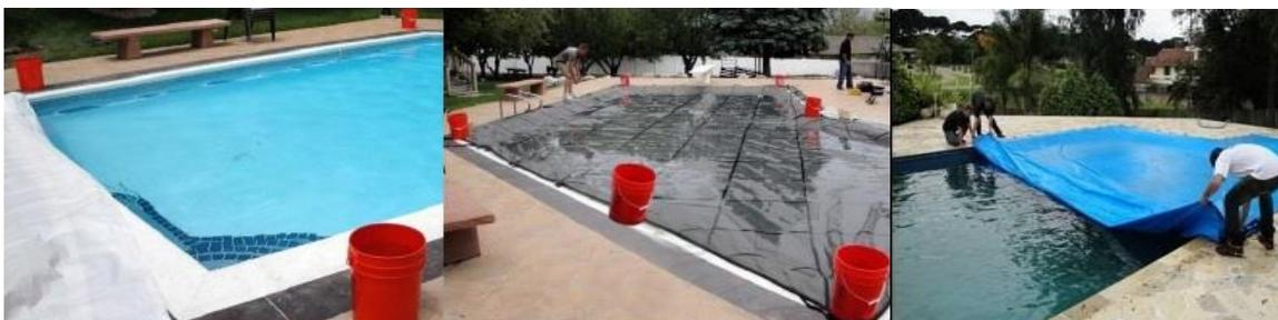
3- Com a Poly-Capa já centralizada, inicie ALINHAMENTO, fazendo UMA LINHA DE GIZ, com DISTÂNCIA DE 15 cm a partir das Argolas "D" aço inox fixadas na bainha da capa e apontando com giz o "X" do exato local do furo de centro a ser feito.
